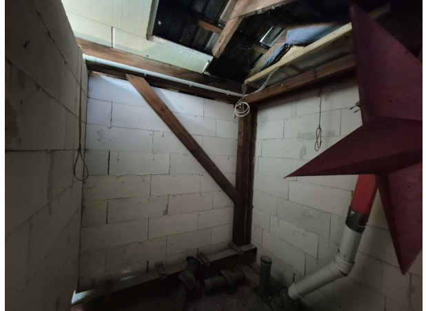
Raum für ein mögliches WC im DG
